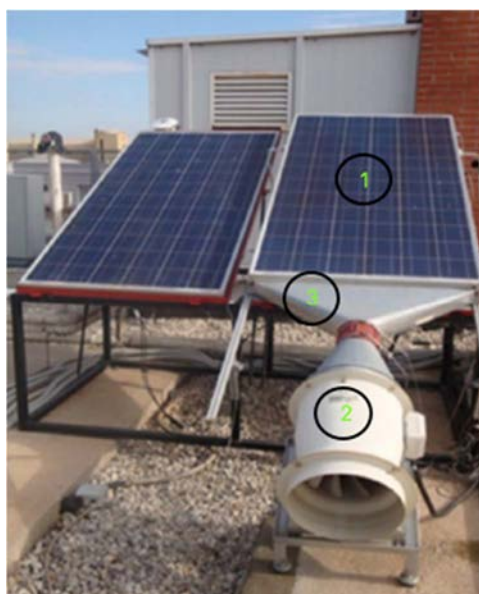
1-光伏组件 2-强制循环风机 3-风道
